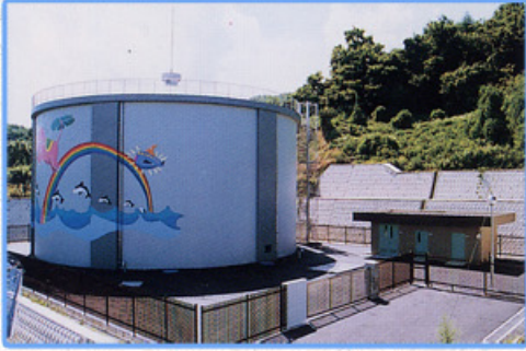
③ 諏訪山配水池
