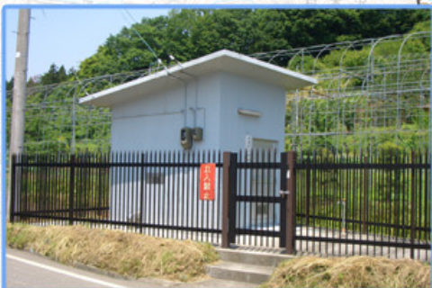
⑦ 長根ポンプ場 山王調整池
